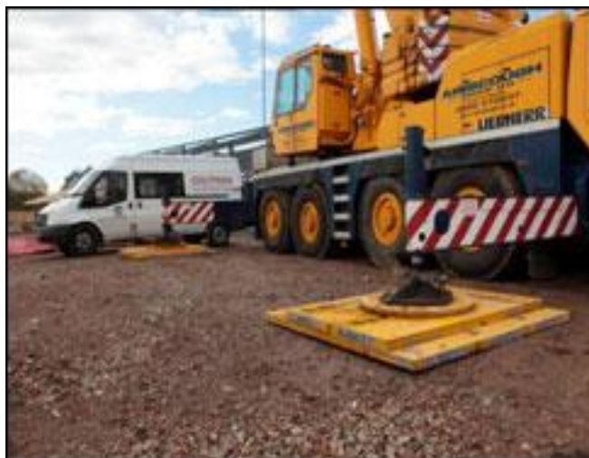
شکل 6. نصب کفپوش زیر جک تعادلی
