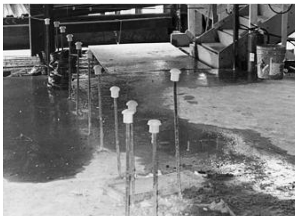
شکل ۱. حفاظ گذاری مناسب بر روی میله گردهای بیرون زده از کف سازه
