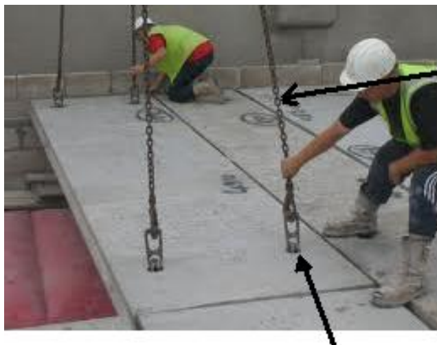
حلقه های نصب شده در بتن قالبی جهت حمل
