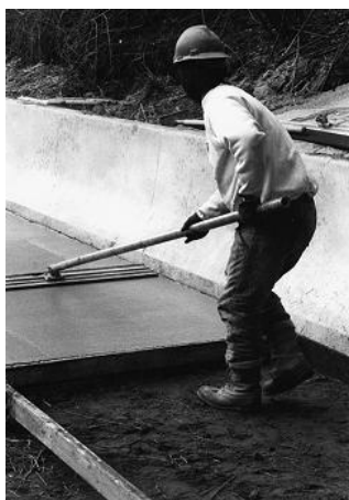
شکل ۸. کارگر در حین کار با ماله دستی بتن
