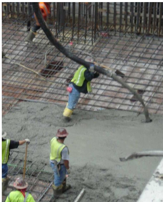
شکل ۷. سیستم پمپاژ بتن به کمک شیلنگ مربوطه
