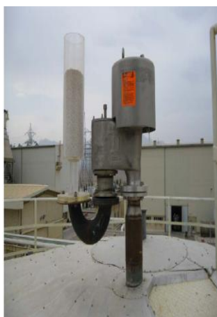
نصب آشکارساز جاذب CO 2 و کیوم بریکر (چپ) و نقشه صحیح نصب آن (راست)
